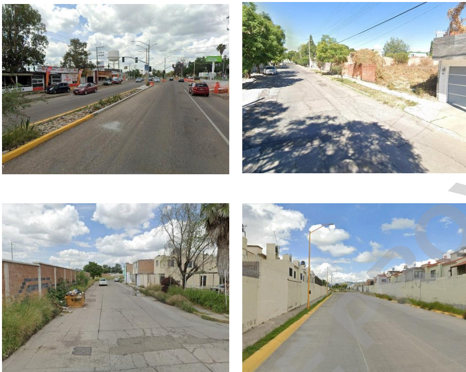
Imagen 9 Contaminación visual en la ZUFO San Pedro Sur
